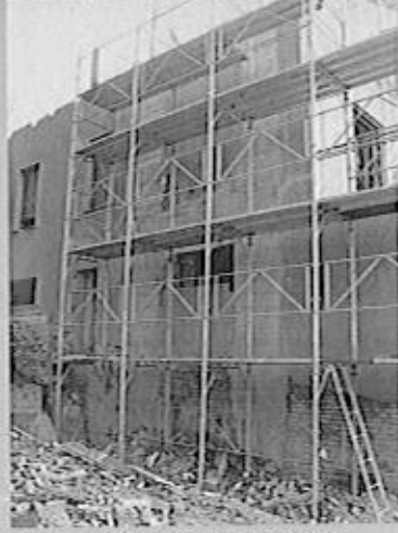
Inserimento telai sismo resistenti nelle pareti in muratura portante
