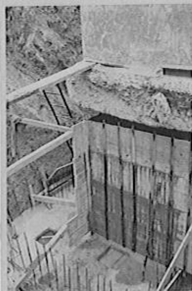
Creazione di piano interrato sotto l'edificio esistente mediante sottomurazioni a conci
