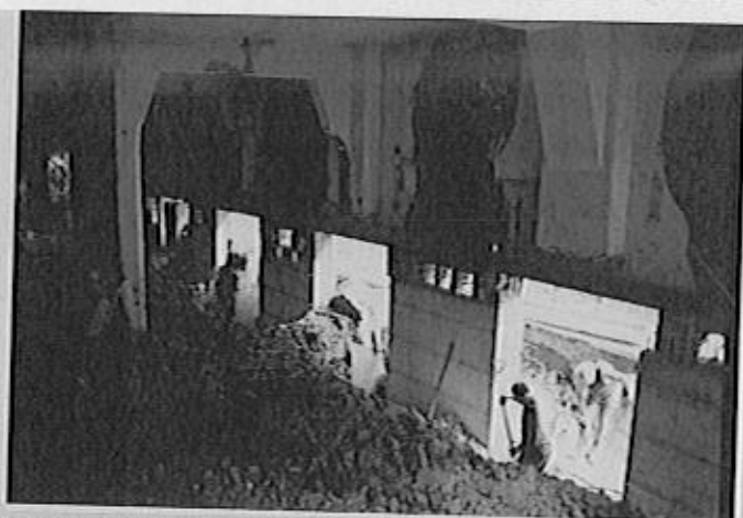
Sottomurazione di intera parete del fabbricato per realizzare un'autorimessa interrata sotto a un capannone in muratura adiacente ad altri palazzi. Vista dall'interno del fabbricato.
