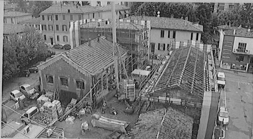
Complesso di edifici vincolato dalla Soprintendenza ai Beni culturali e ambientali
