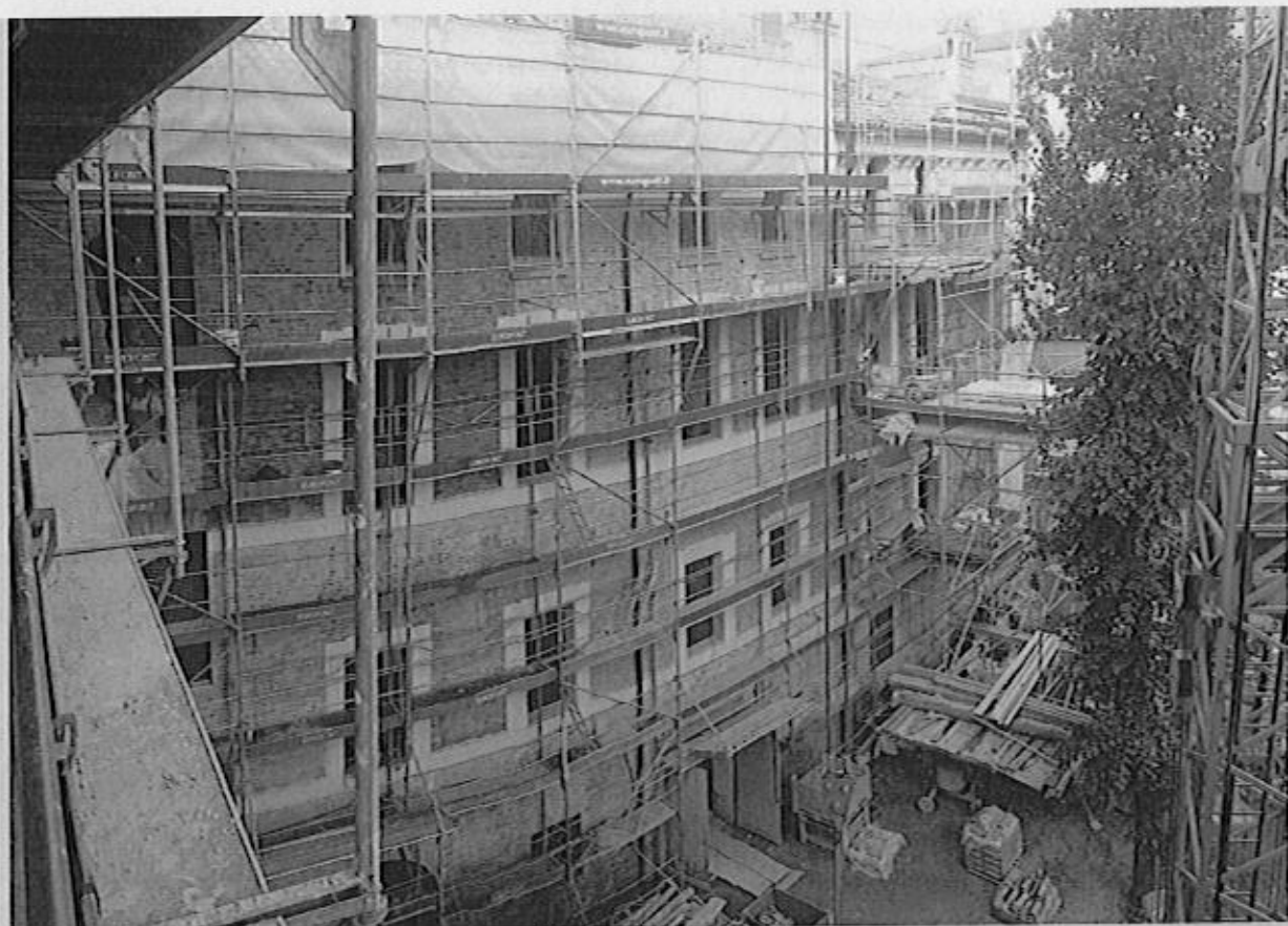
Cantiere. Cortile interno.
