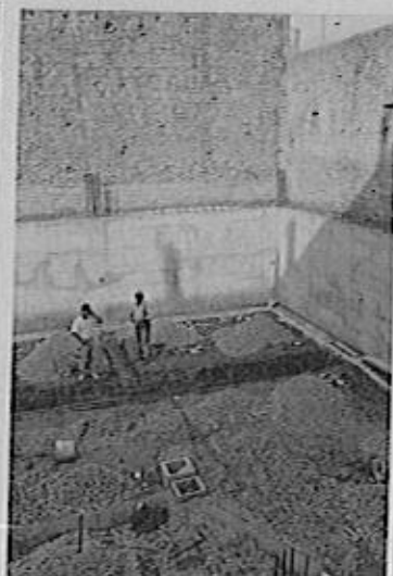
Sottomurazione del capannone in muratura adiacente ad altri palazzi ed al fabbricato principale. Da sinistra a destra: interno capannone prima dei lavori, durante la sottomurazione, a sottomurazione finita dopo la demolizione della vecchia copertura in legno.
