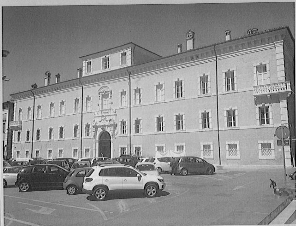
Facciata su piazza Kennedy alla fine dei lavori.
