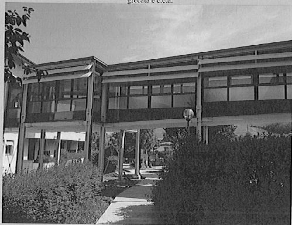
Corpo di collegamento a lavori ultimati
