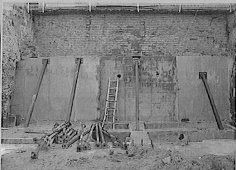
Conci di parete sotto le fondazioni dell'edificio principale
