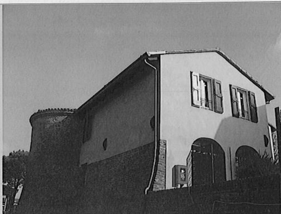
Prospetto sud ed ovest dopo i lavori
