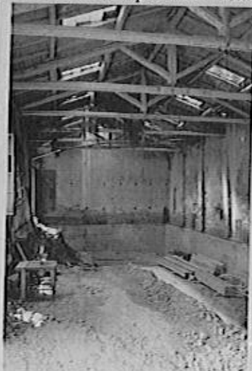
Sottomurazione del capannone in muratura adiacente ad altri palazzi ed al fabbricato principale. Da sinistra a destra: interno capannone prima dei lavori, durante la sottomurazione, a sottomurazione finita dopo la demolizione della vecchia copertura in legno.
