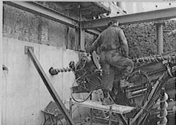
Esecuzione di tiranti in roccia
