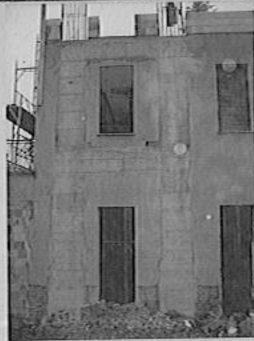
Inserimento telai sismo resistenti nelle pareti in muratura portante
