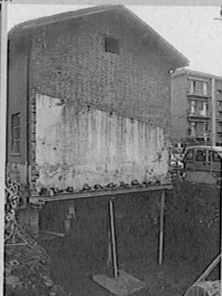
Sostegno provvisorio di un corpo di fabbricato durante la costruzione di un piano interrato adiacente
