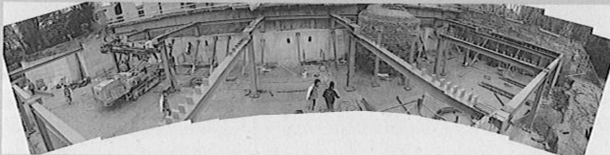
Telaio in acciaio a supporto del soffitto di copertura
