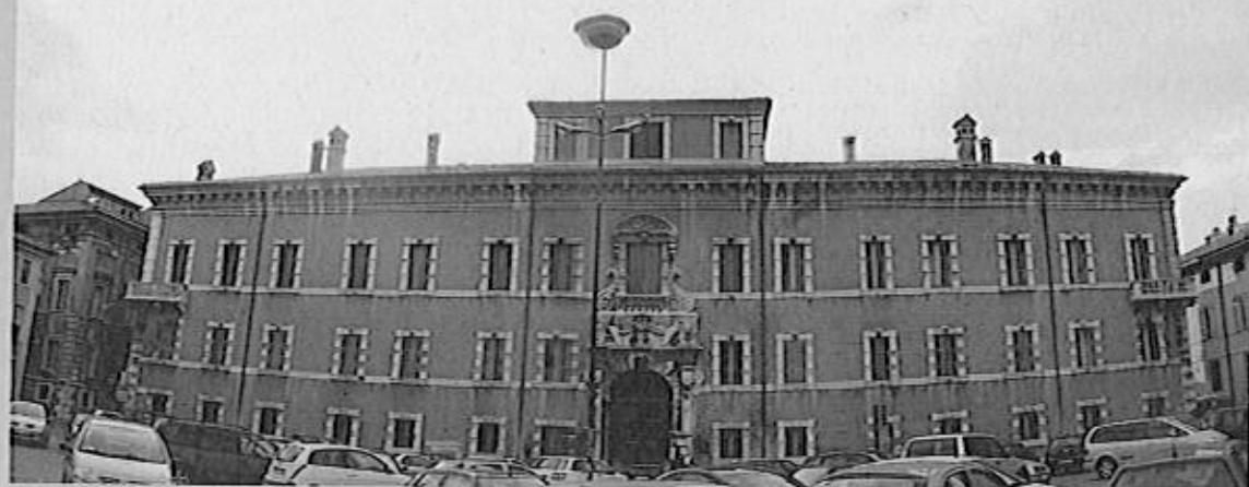
Facciata su piazza Kennedy prima dei lavori.
