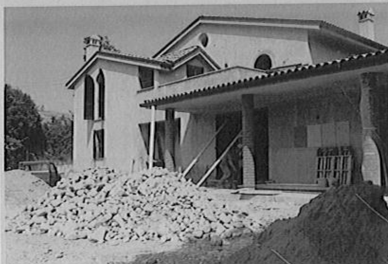
Creazione di piano interrato sotto l'edificio esistente mediante sottomurazioni a conci
