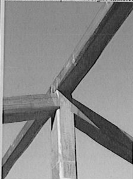
Nodo capriata-trave in colmo durante la costruzione
