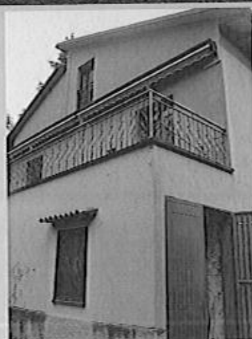
Edificio prima dei lavori
