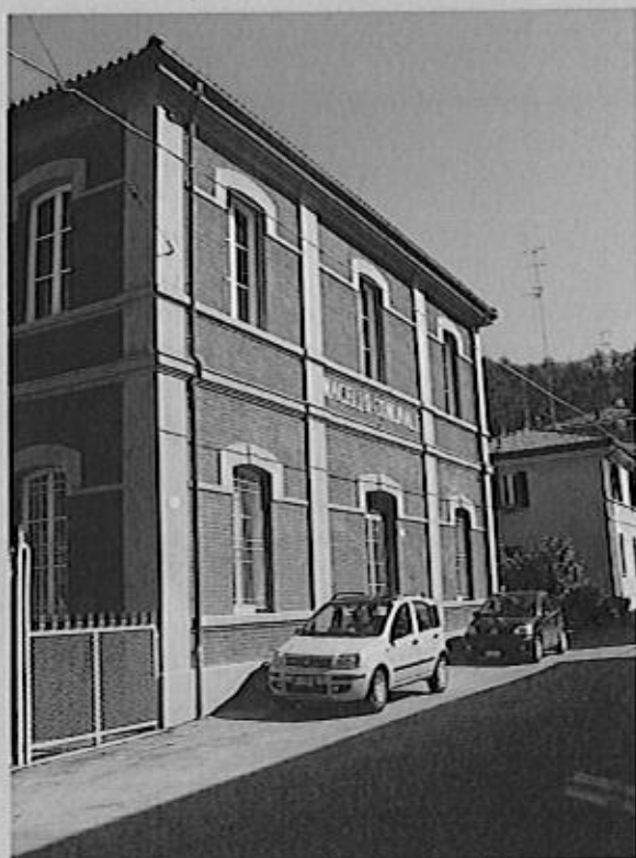
Prospetto sud a fine lavori
