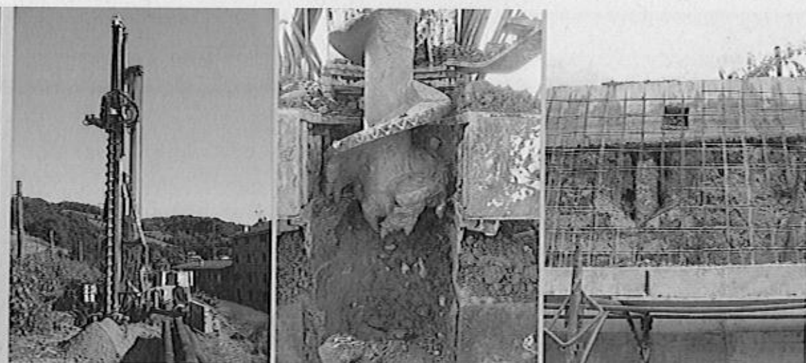
Lavori in corso d'opera
