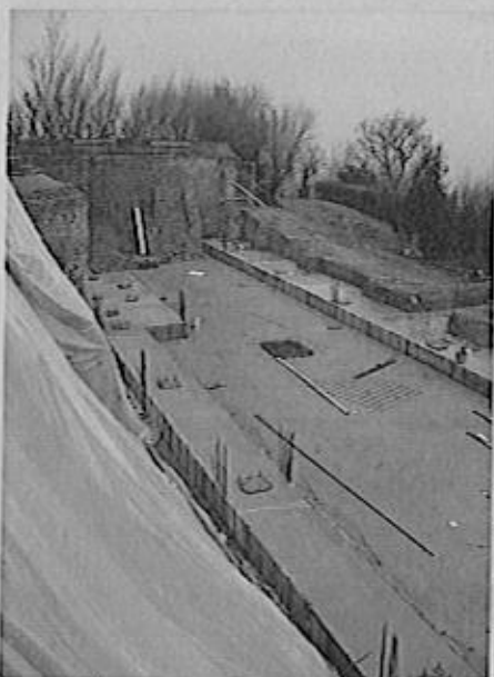
Scavo di sbancamento
