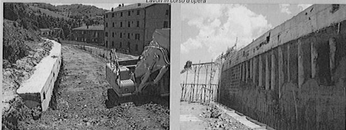
Lavori in corso d'opera
