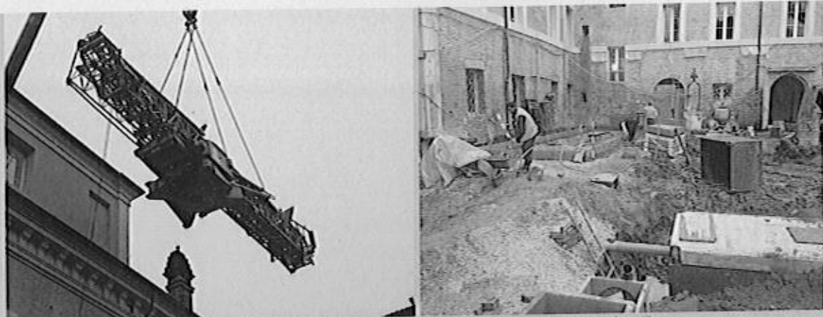
Cantiere. Smontaggio gru a torre e opere di sistemazione esterna nel cortile
